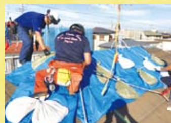
消防ボランティアによる屋根へのブルーシート掛け
