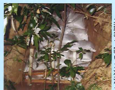
土嚢等で塞いだ状況
