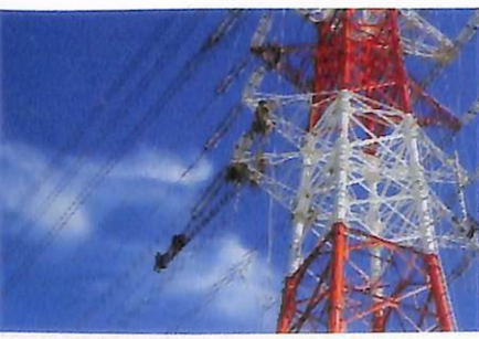
鉄塔上の作業員・高澤委員
